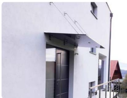
Vordach mit Zugstangen
