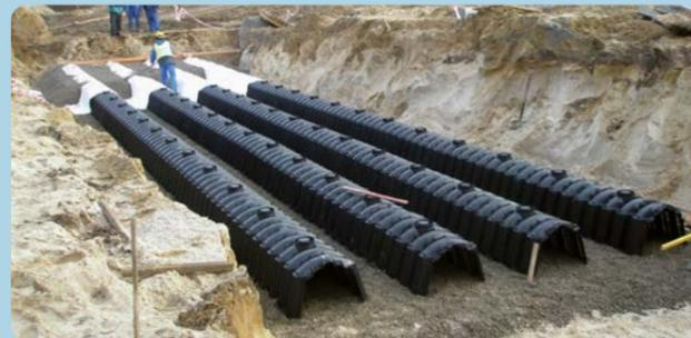
Sicker-Tunnel und Sicker-Tunnel Twin können auch kombiniert werden.
