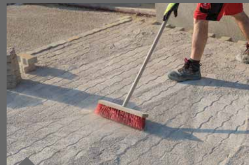
Verfugen in ungebundener Bauweise
