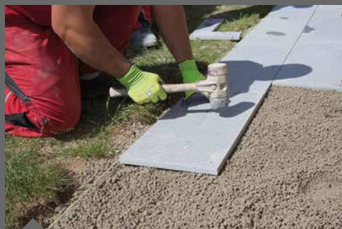
Pflastern in gebundener Bauweise
