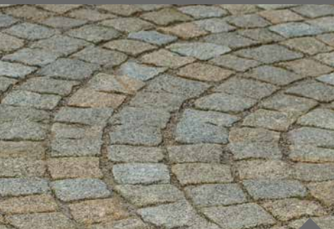
Verfugung in ungebundener Bauweise
