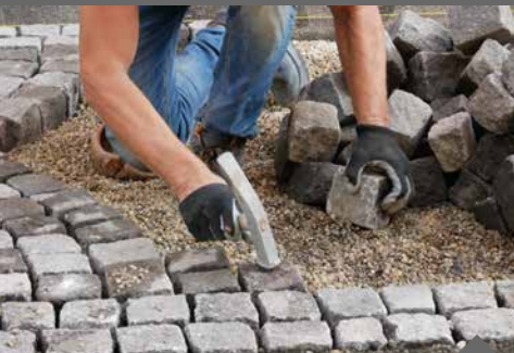
Pflastern in ungebundener Bauweise
