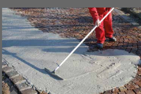
Verfugen in gebundener Bauweise
