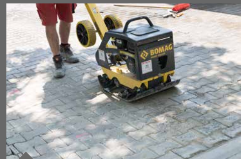
Abrütteln in ungebundener Bauweise
