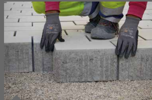
Verlegen in ungebundener Bauweise
