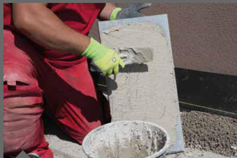
Verkleben in gebundener Bauweise
