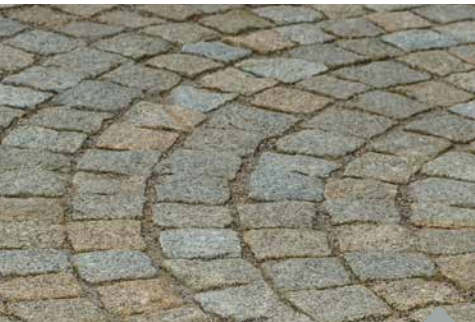
Verfugung in ungebundener Bauweise
