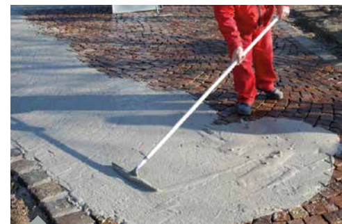
Verfugen in gebundener Bauweise
