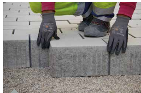
Verlegen in ungebundener Bauweise
