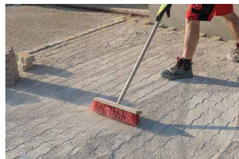
Verfugen in ungebundener Bauweise
