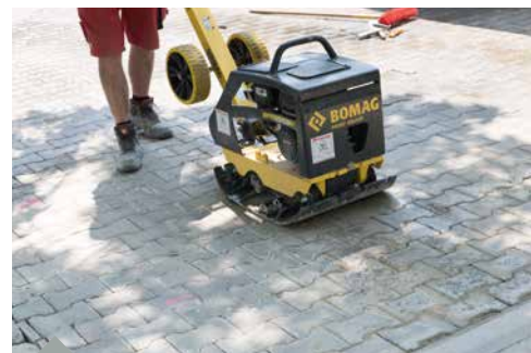
Abrütteln in ungebundener Bauweise
