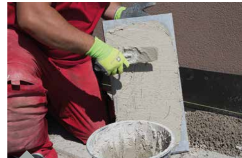
Verkleben in gebundener Bauweise
