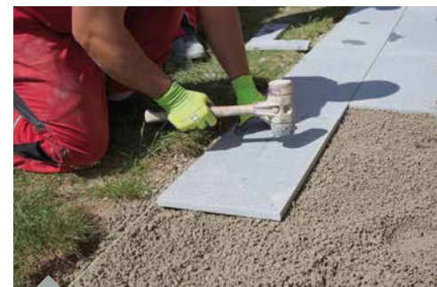
Pflastern in gebundener Bauweise
