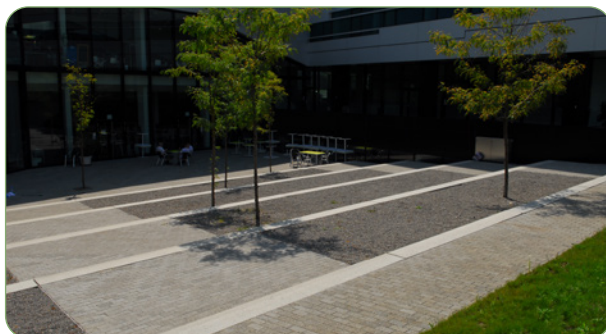
Abbildung 6: Haufwerksporige Betonstein- und Plattensysteme
