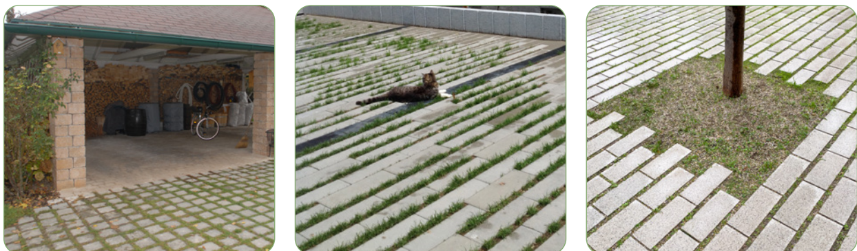
Abbildung 4: Betonstein mit aufgeweiteter Sickerfuge und kapillarer Grünfugenfüllung
