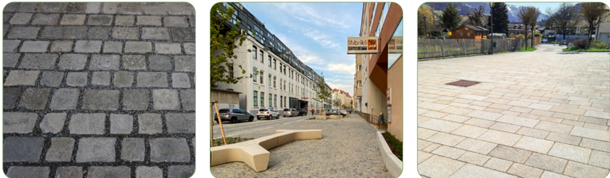
Abbildung 3: Betonstein mit aufgeweiteter Sickerfuge und kapillarbrechender Splittfüllung
