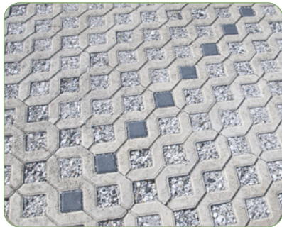
Abbildung 5: Rasengittersysteme, deren Hohlkammern mit Splitt- oder Rasen gefüllt sind
