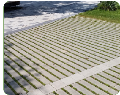
Abbildung 5: Rasengittersysteme, deren Hohlkammern mit Splitt- oder Rasen gefüllt sind
