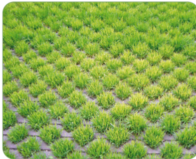
Abbildung 5: Rasengittersysteme, deren Hohlkammern mit Splitt- oder Rasen gefüllt sind
