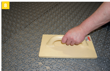
8 IndorTec® THERM-E flächig andrücken oder anrollen.
