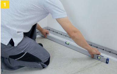
1 Prüfung des Untergrundes auf Eignung und Ebenföchigkeit. Gegebenfalls sind Ausgleichsarbeiten durchzuführen.
