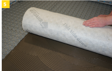
5 IndorTec® THERM-E in zugeschnittener Form mit dem Vlies in die noch frische Klebemörtelschicht einbetten.
