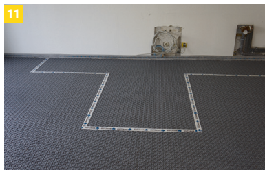
11 Heizfreie Zonen müssen vor Verlegung der Heizkabel gekennzeichnet und ausgespart werden. Diese müssen im beigelegten Verlegeplan skizziert werden.
