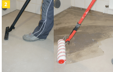
2 Säubern und Grundieren des Untergrundes.
