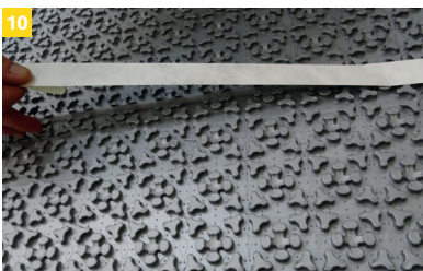
10 Bei Bauteil- und vorhandenen Bewegungsfugen (Details siehe „Fugen“, Seite 2) sind die Matten auf die vorgegebene Breite, mind. 8 mm, zu trennen und mit AquaDrain® UB Universalband zu überdecken. Feldbegrenzungsfugen zur Unterteilung großflächiger Belagsflächen werden auf IndorTec® THERM-E ausgebildet. Warmleiter der Heizkabel dürfen nicht über Bauteil- und Bewegungsfugen verlegt werden.
