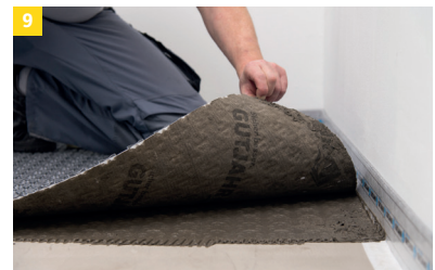
9 So wird eine vollflächige Einbettung zum Untergrund erreicht. Weiterführende Arbeiten erfolgen nach Erhärtung der Verklebung von IndorTec® THERM-E.
