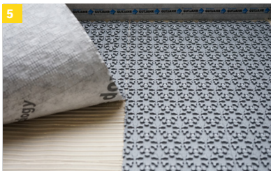
5 IndorTec® THERM-E in zugeschnittener Form mit dem Vlies in den Klebstoff einbetten.
