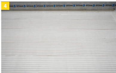
4 Klebstoff mit geeigneter Zahnleiste auftragen.
