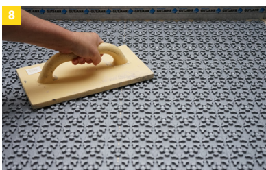
8 IndorTec® THERM-E flächig andrücken oder anrollen.
