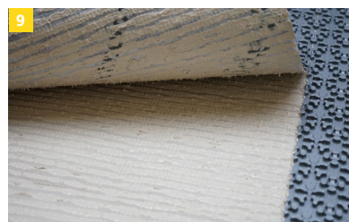
9 Somit wird eine vollflächige Einbettung zum Untergrund erreicht. Weiterführende Arbeiten erfolgen nach Erhärtung der Verklebung von IndorTec® THERM-E.
