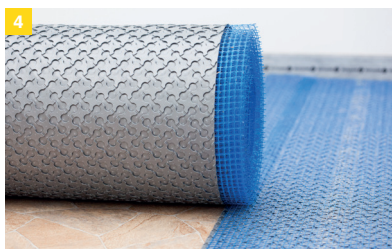
4 ... die bereits zugeschnittene IndorTec FLEXBONE® 2E lose auf dem Untergrund ausrollen (oder bei Plattenware „auslegen“).
