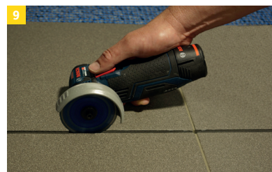
9 Erfolgt die Ausbildung der Bewegungsfuge in der Entkopplung nach der Belagsverlegung ist IndorTec FLEXBONE® 2E mit einem Fugenschneider auf ganze Fugenbreite auszuschneiden.
