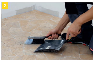
2 Säubern des Untergrundes. Ein Grundieren kann entfallen.
