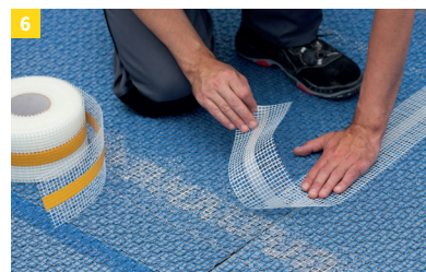
6 Mattenstöße an Kopfenden und angeschnittenen Teilflächen ohne Überlappung werden mit Watec® ST Stoßarmierung verbunden.
