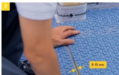
7 Die Ausbildung von Bewegungsfugen in IndorTec FLEXBONE® 2E erfolgt wie unter dem Kapitel Fugen beschrieben. Wird die Entkopplung vor der Belagsverlegung auf Fugenbreite getrennt...
