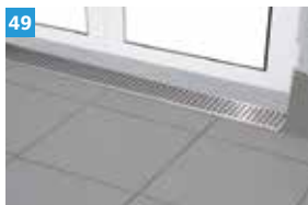
49 Ansicht des fertigen Belages bei niedrigem Türanschluss mit Watec® Drain RD-QE Drainrinne.
