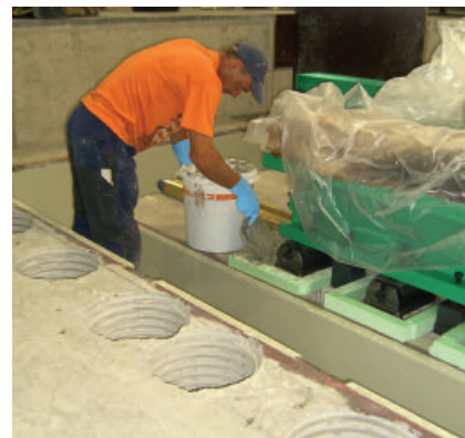
Verguss einer Maschinenverankerung mit PCI Repaflow Plus
