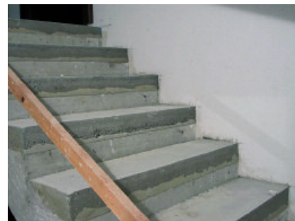
Aufgrund seiner Eigenschaften eignet sich PCI Novoment M3 plus auch hervorragend zum Höhenausgleich von Betontreppenstufen.
